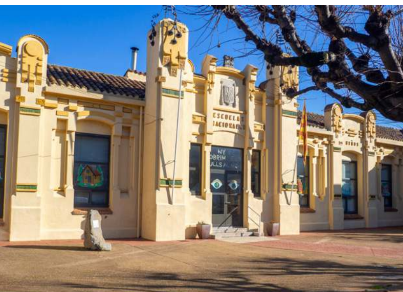
Edifici històric de les escoles del poble.
