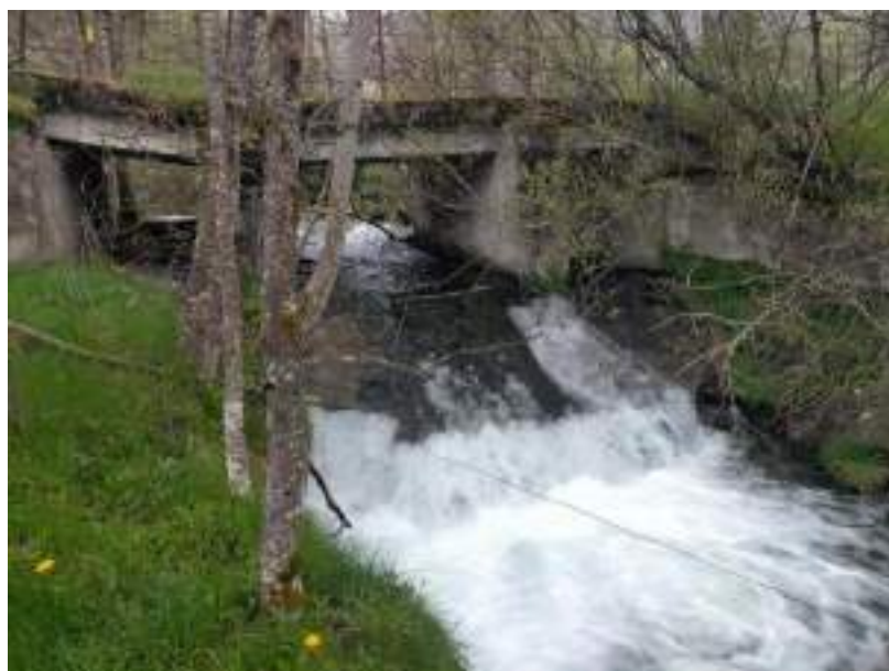
Imatge del salt que es forma per la construcció de ME04, sent una barrera probablement infranquejable per la fauna aquàtica
