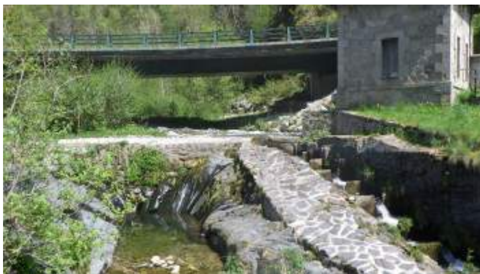
Resclosa del Pontitxol, amb el dispositiu per al pas dels peixos al marge esquerre del Ter
