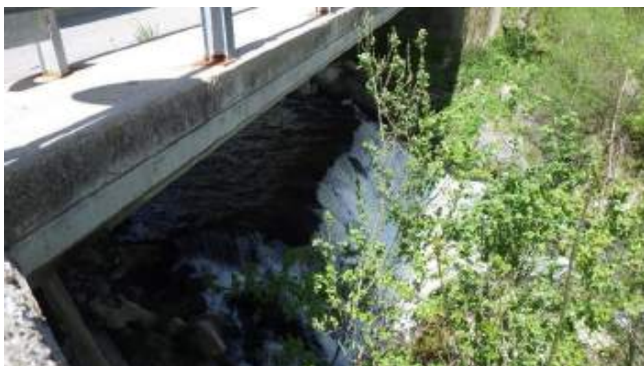
Pont amb un salt, probablement per l'alteració de la llera per la construcció d'aquest (SE07)
