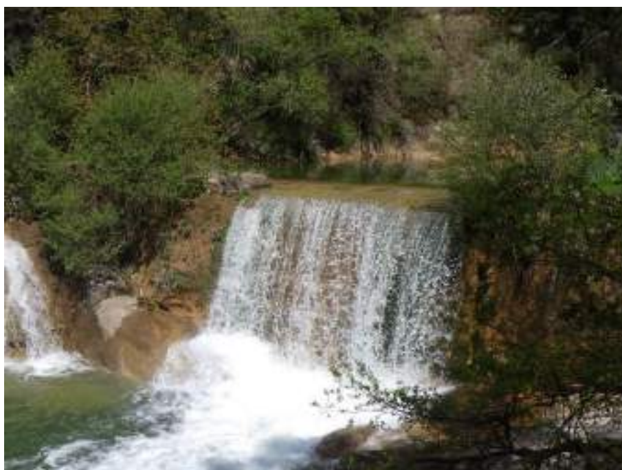
Resclosa de l'antic molí de Danyans, on es va rebaixar la resclosa per recuperar la dinàmica natural
